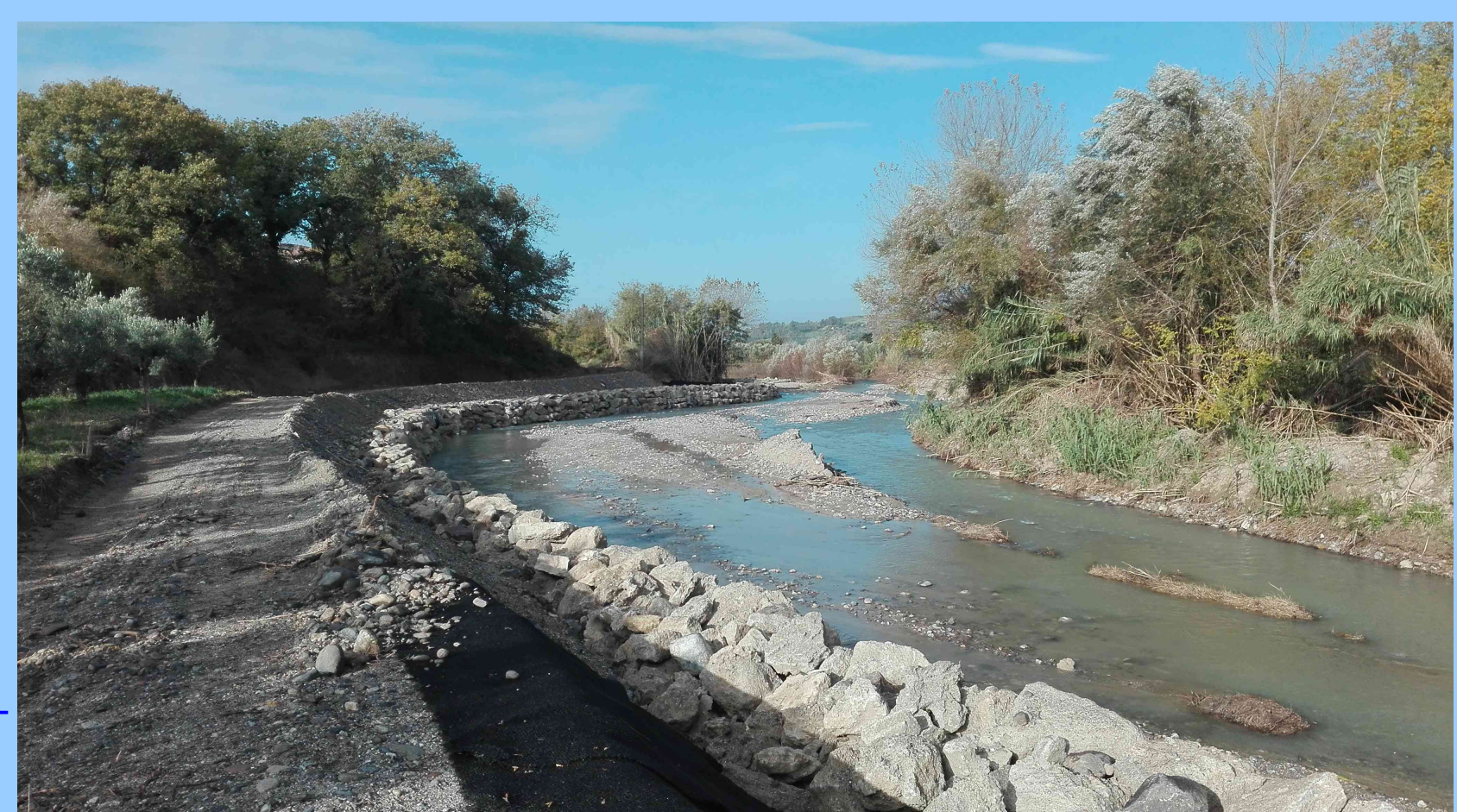
Fig. 5 – Fiume Pesipe – Protezione spondale in massi ciclopici
