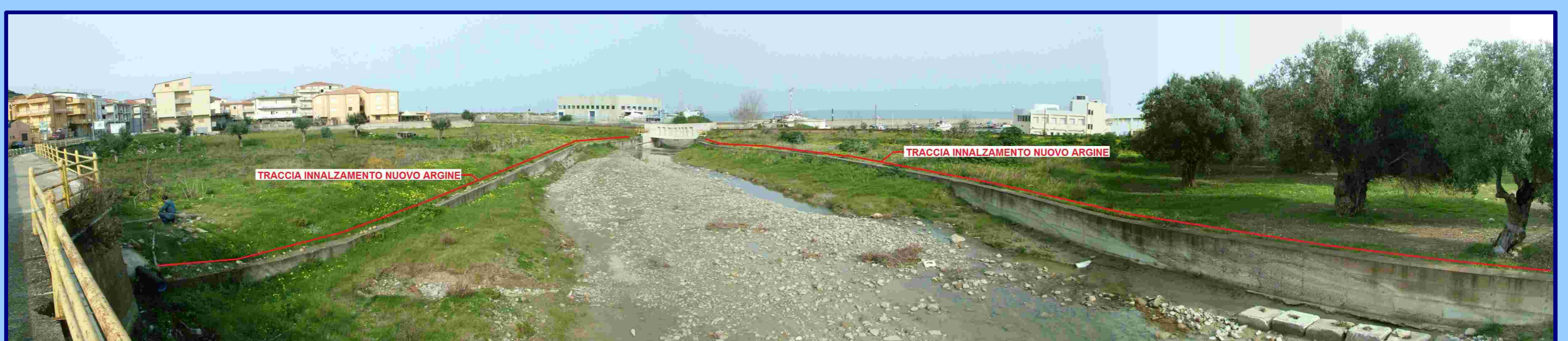
Fig. 4 - Foto tratto compreso tra il ponte della SS 106 e quello ferroviario – Traccia innalzamento argin
