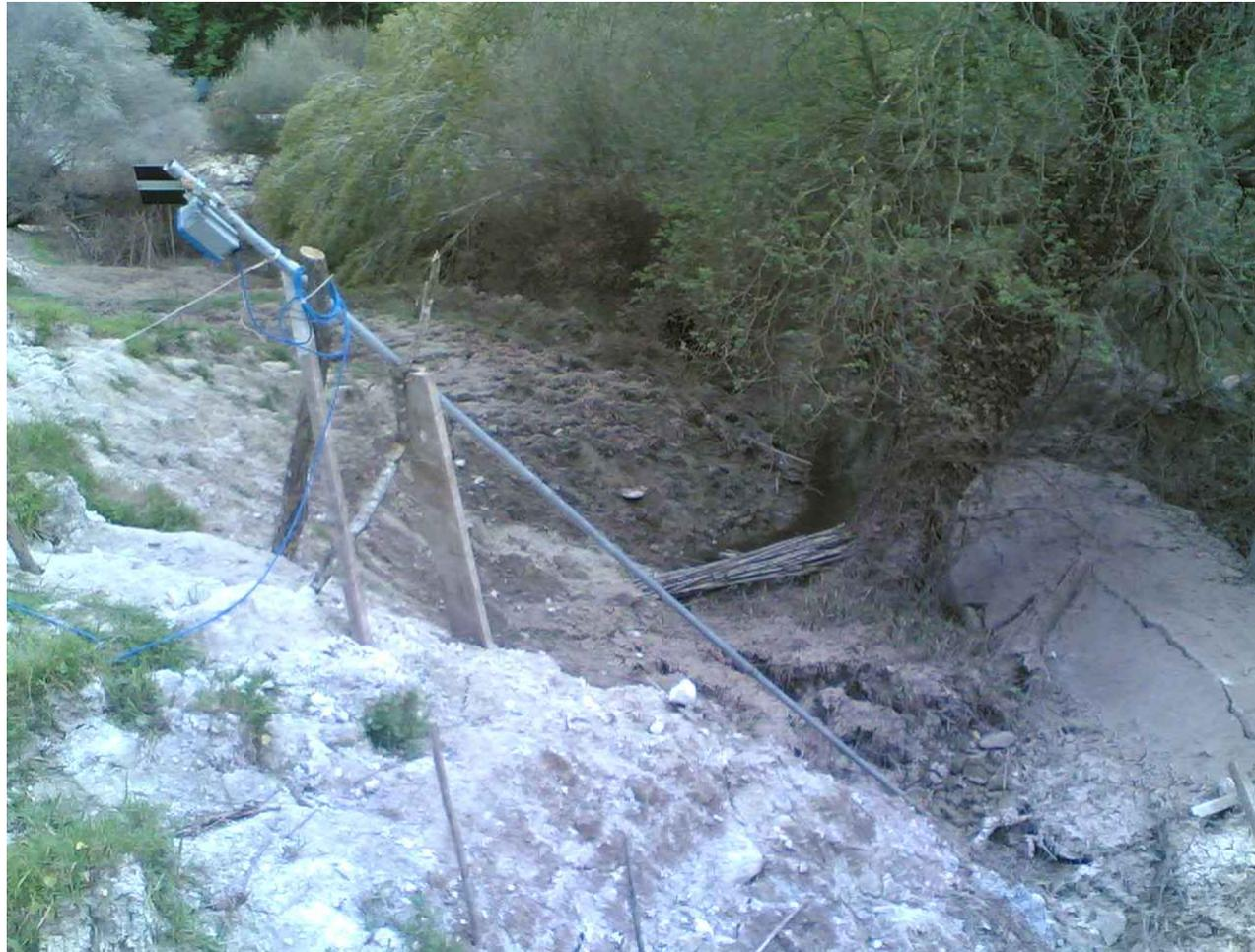
Fig. B14: Particolare piezometro – Ultima installazione
